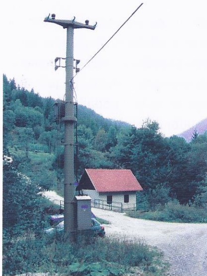
Objekt male pretočne hidroelektrarne
